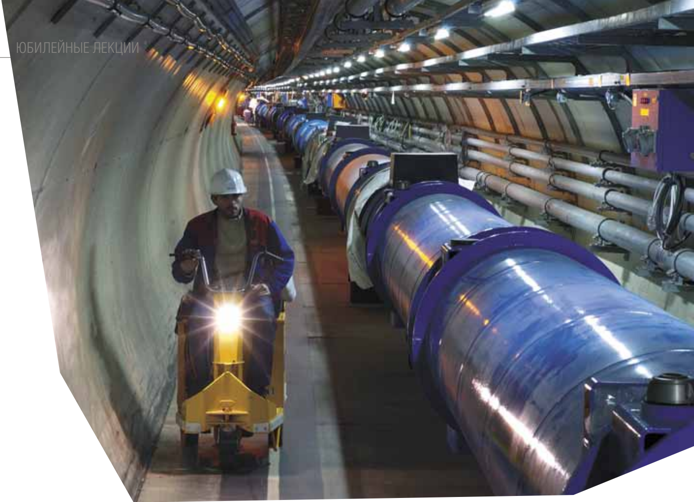
Так выглядит тоннель Большого адронного коллайдера. Для передвижения по многокилометровому кольцу инженеры и техники, обслуживающие ускоритель, вынуждены пользоваться транспортными средствами (в том числе обычными велосипедами). © CERN
